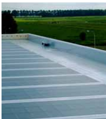
Grote platte daken met dakbedekking met flexibele PV
