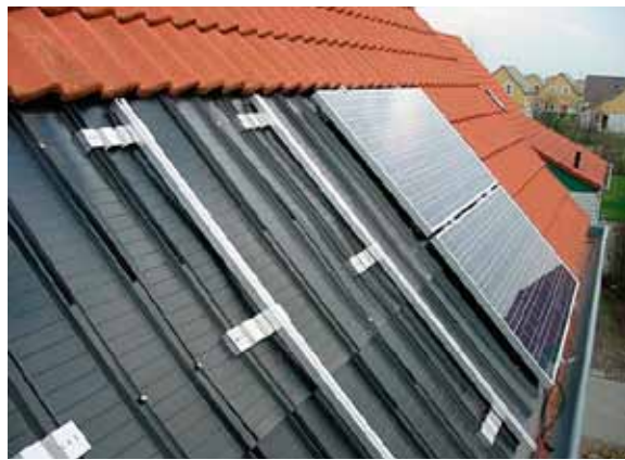
Een systeem tussen de bestaande dakbedekking
