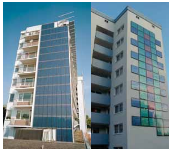
Een voorbeeld van PV geïntegreerd in een kopgevel in Delft en Duitsland
