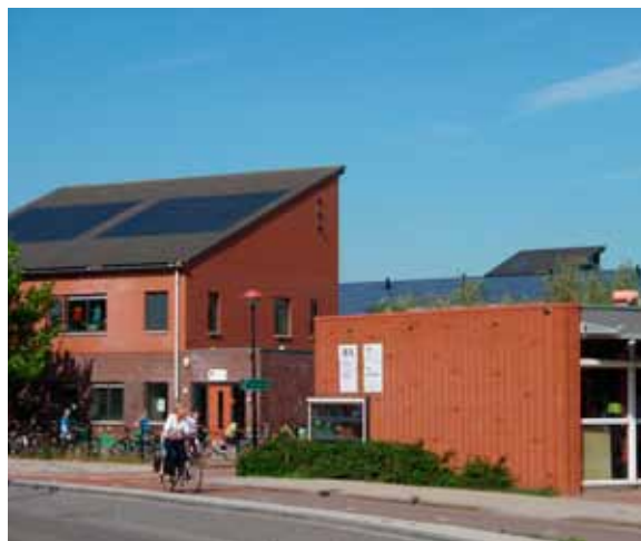
Een dak met PV-dakpannen in Nieuwland, Amersfoort
